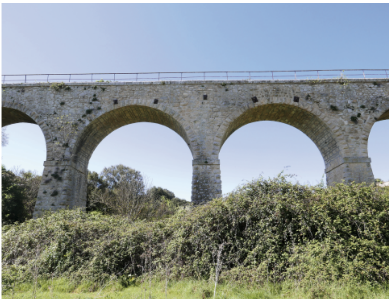
Fig. 9. Il ponte ferroviario di Isili (Sardegna) che ospitava nel 2023 almeno 6 colonie di Apis mellifera . Foto Paolo Fontana.
